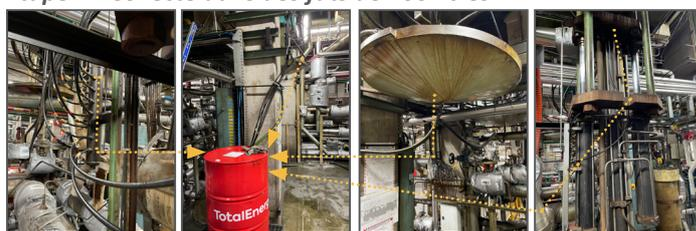
40 fûts de récupération d'huile de 200 litres sur rétention sont disposés au sous-sol. (1 par presse, 2 en fin de ligne, 1 mobile).
